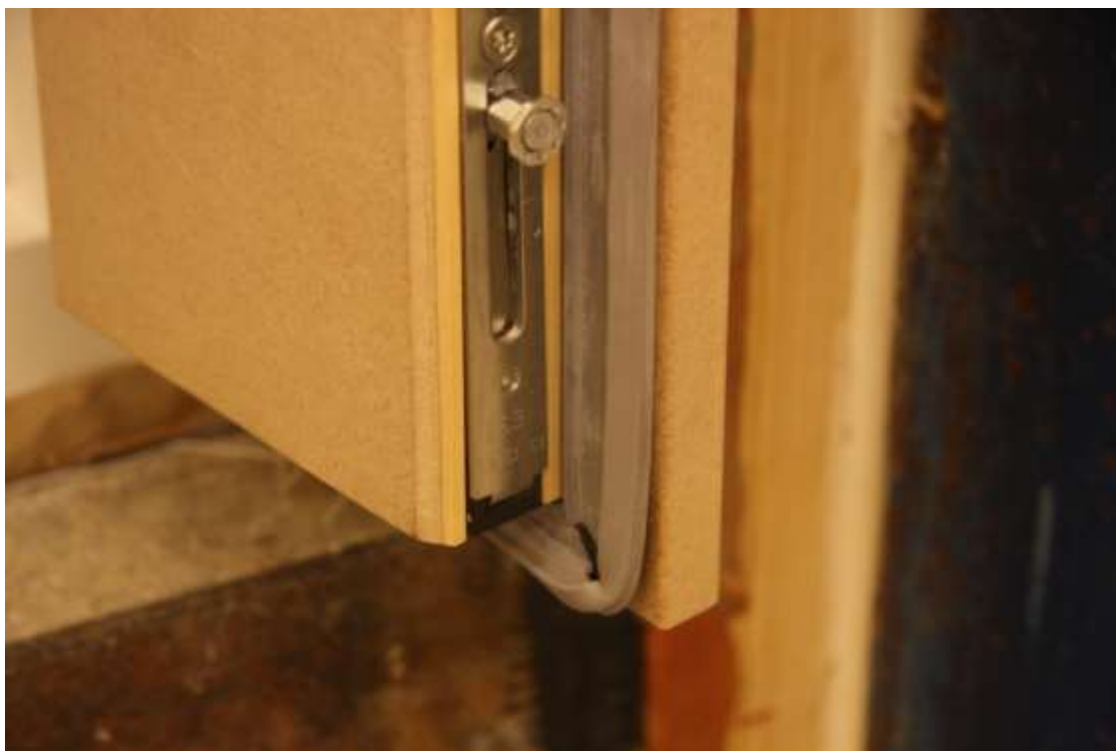
Bild 17 - Vädringsluckan av 16 mm board på insidan, bilaga 3..
