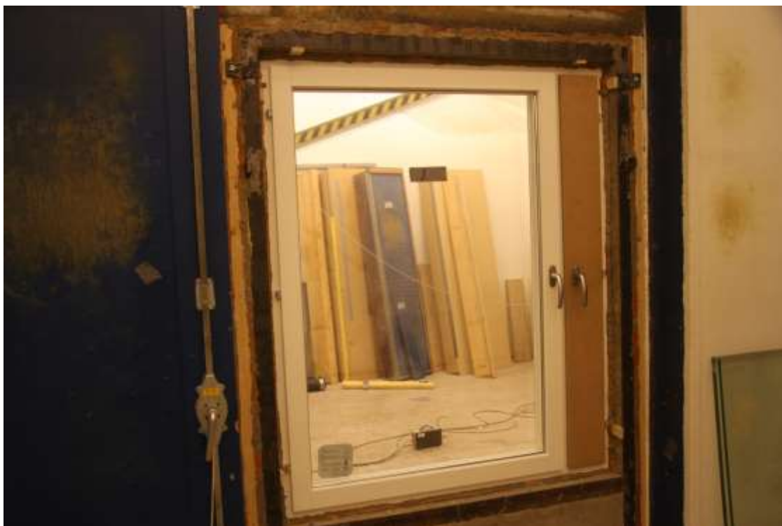
Bild 15 - Fönstret med vädringslucka av 16 mm board på insidan, bilaga 3.
