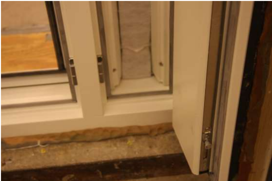
Bild 5– Fönstret i bilaga 1, vädringsluckan i 4 mm board.
