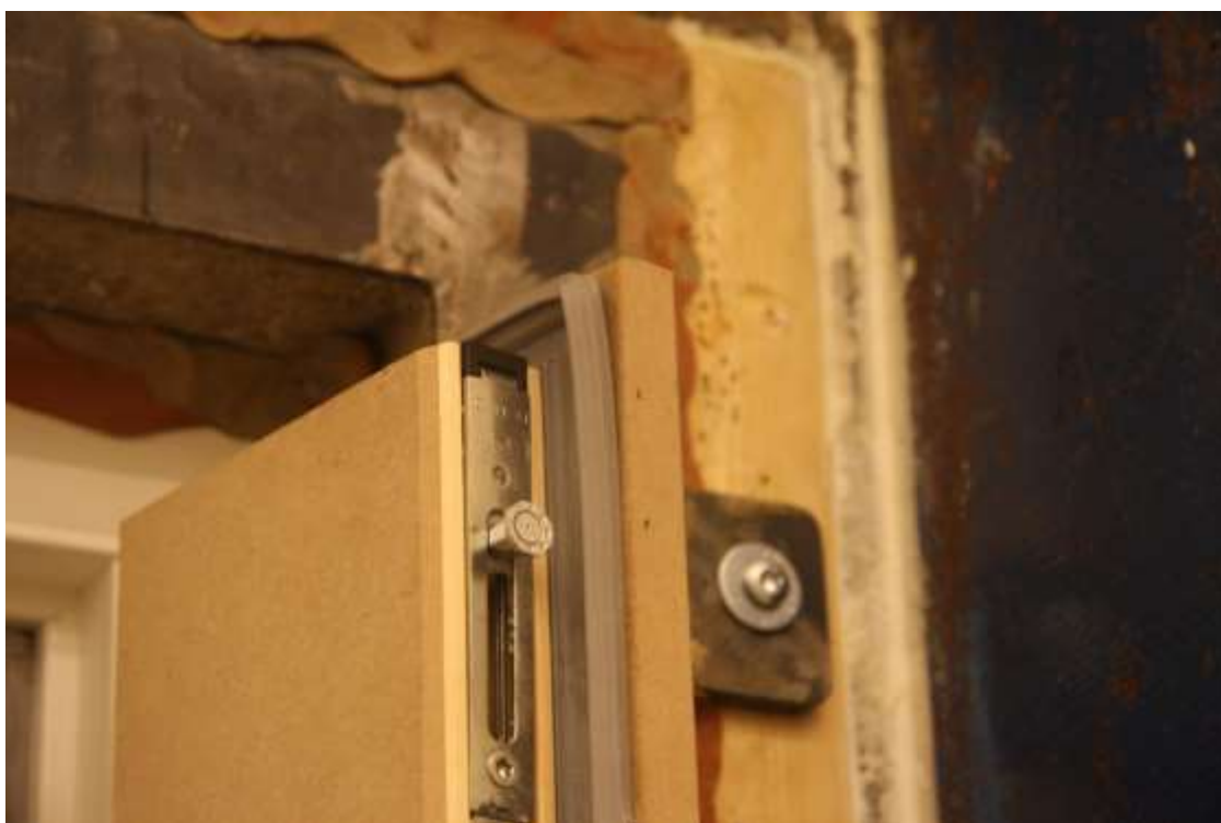
Bild 16 - Vädringsluckan av 16 mm board på insidan, bilaga 3.
