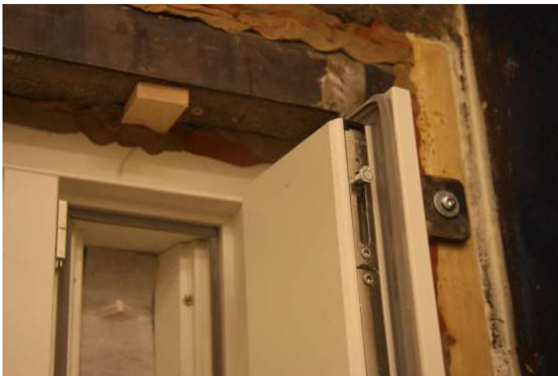
Bild 4– Fönstret i bilaga 1, vädringsluckan i 4 mm board.
