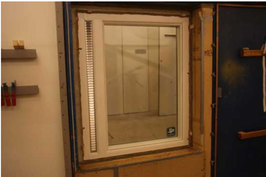
Bild 6 – Fönstret från utsidan.
