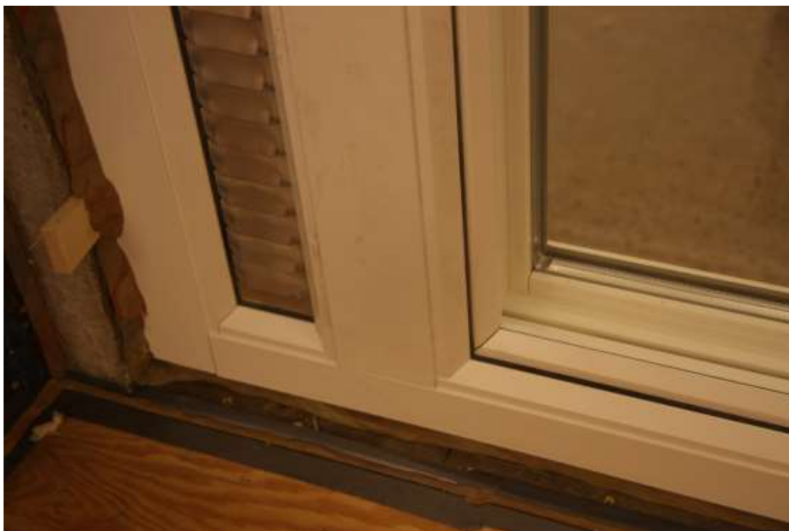
Bild 7 – Fönstret från utsidan.
