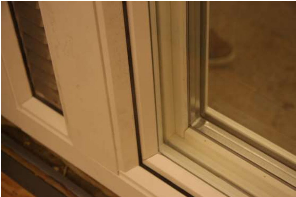
Bild 7 – Fönstret från utsidan.
