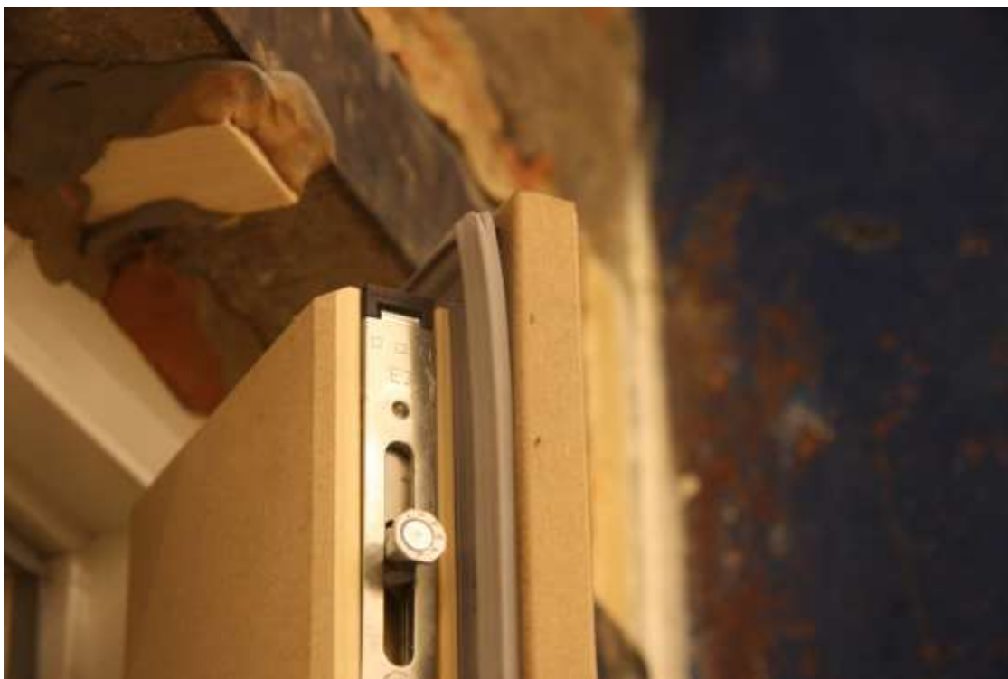
Bild 4– Fönstret i bilaga 1, vädringsluckan i 16 mm board.
