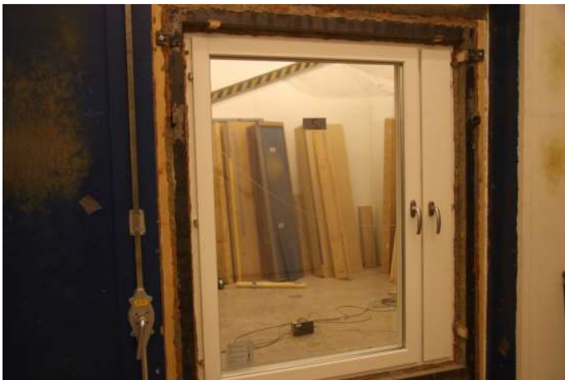
Bild 13 – Fönstret med vädringslucka av 4 mm board på insidan, bilaga 2.
