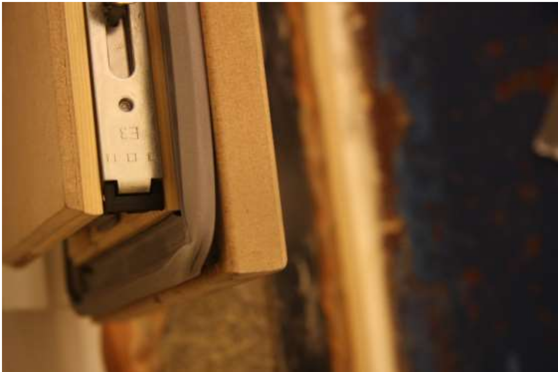
Bild 5– Fönstret i bilaga 1, vädringsluckan i 16 mm board.
