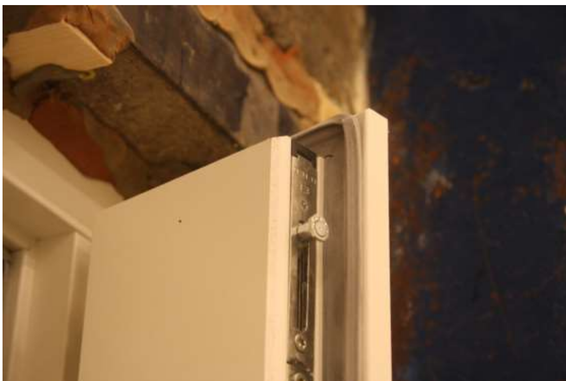
Bild 14 - Fönstret med vädringslucka av 4mm board på insidan, bilaga 2.
