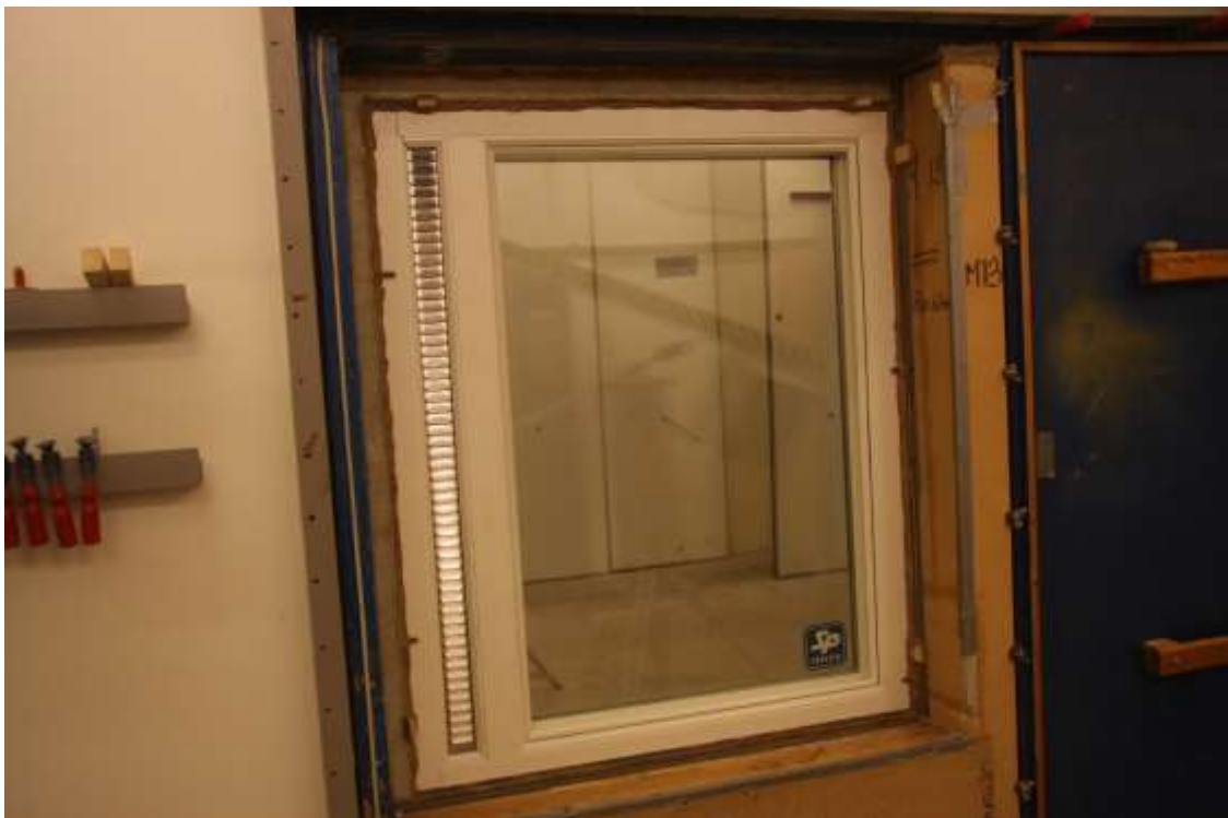
Bild 6 – Fönstret från utsidan.
