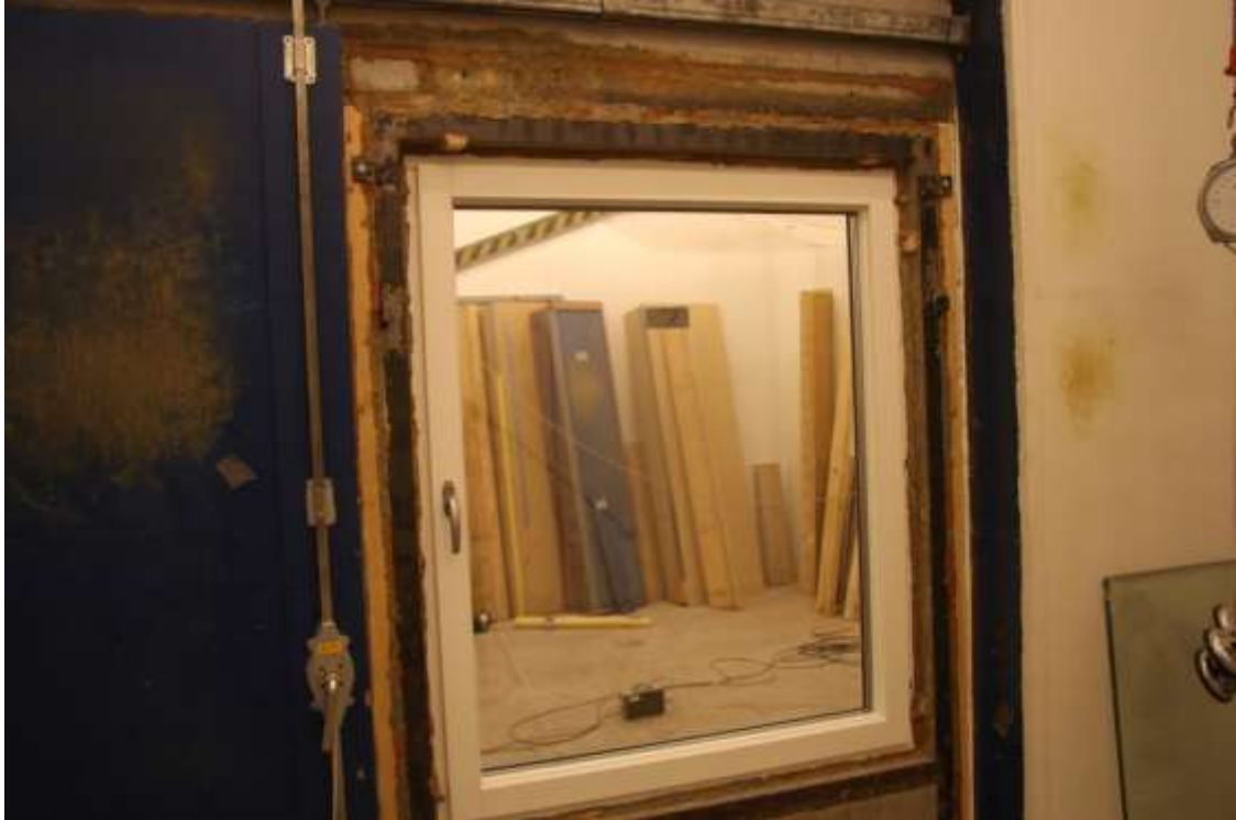
Bild 1 – Fönstret från insidan.
