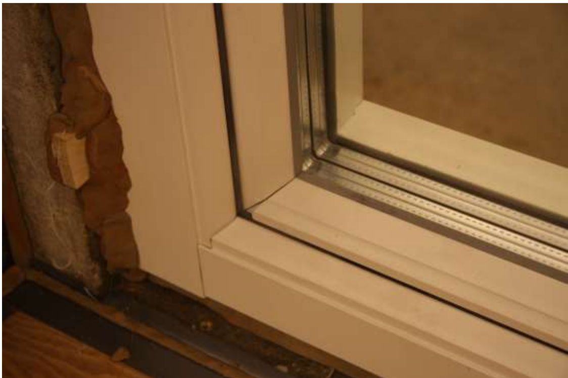
Bild 4 – Fönstret från utsidan.
