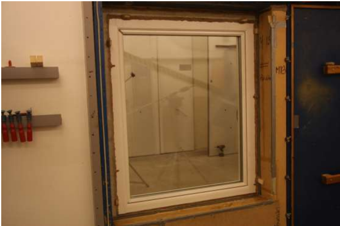
Bild 3 – Fönstret från utsidan.
