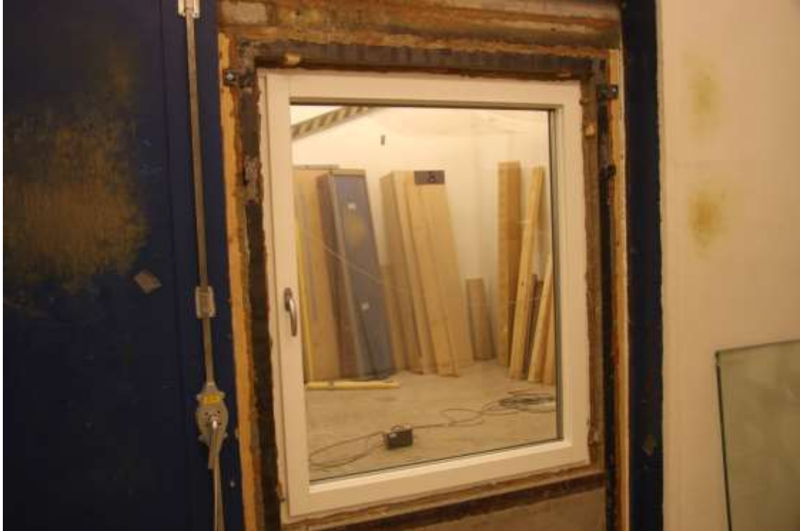
Bild 1 – Fönstret från insidan.
