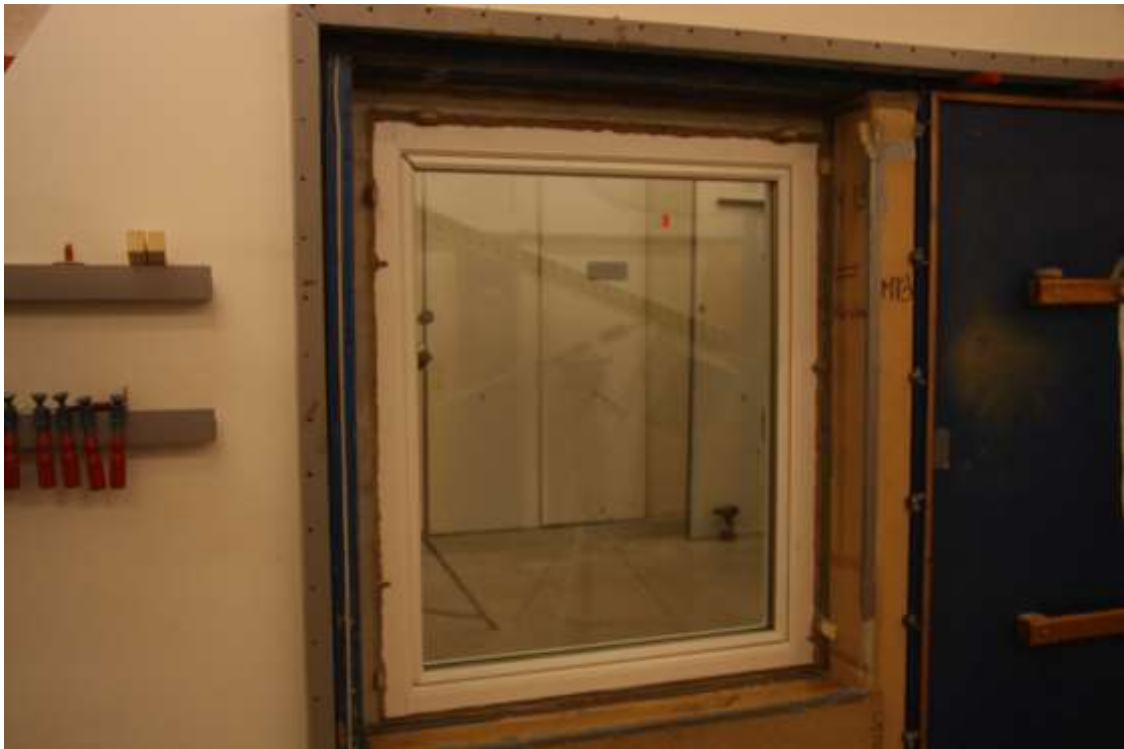
Bild 3 – Fönstret från utsidan.
