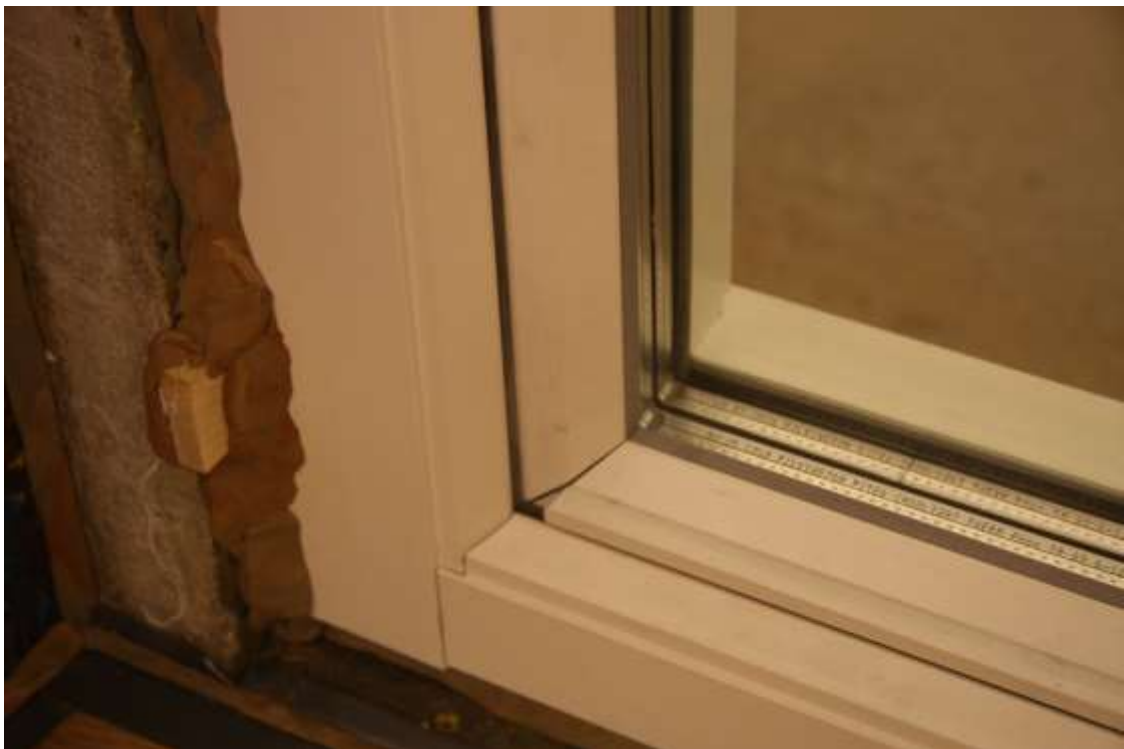
Bild 4 – Fönstret från utsidan.
