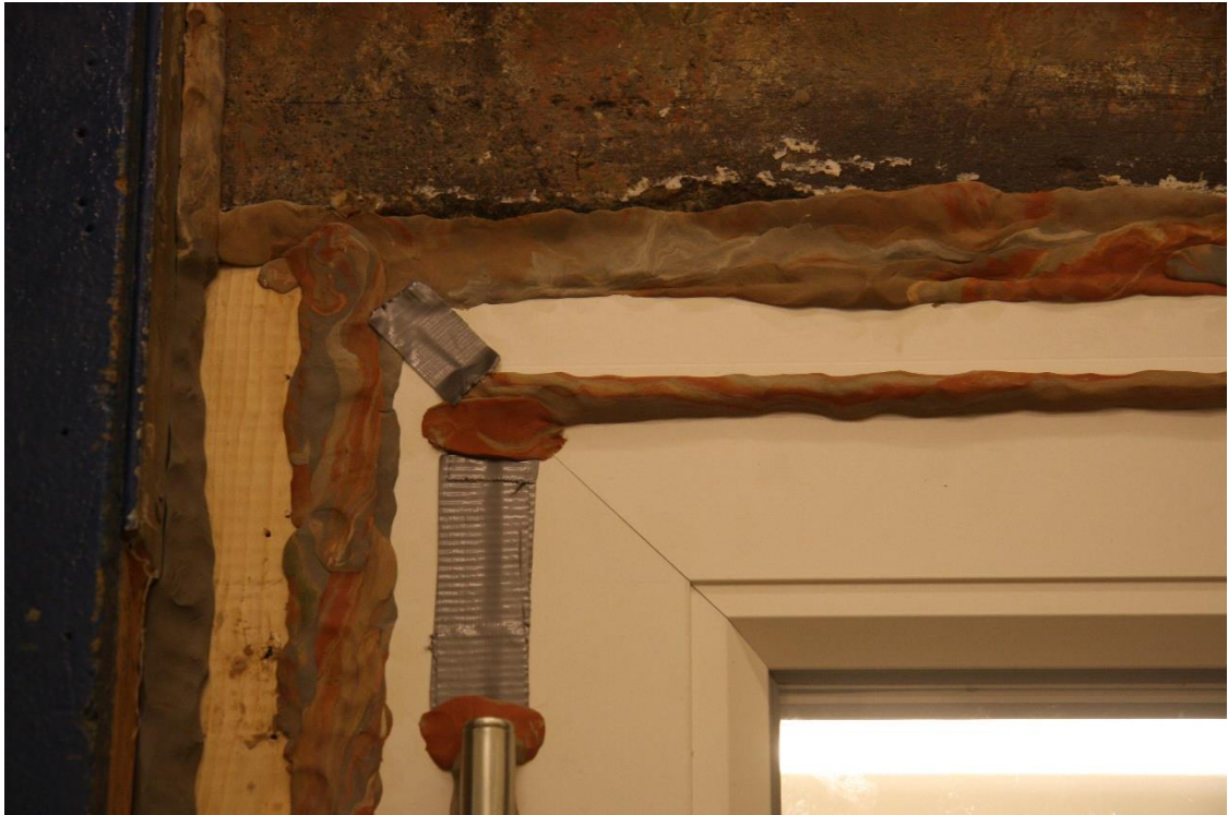
Bild 9 – Dörrens utsida tätad med tejp och modelleras mellan karm och båge, bilaga 2 och 3
